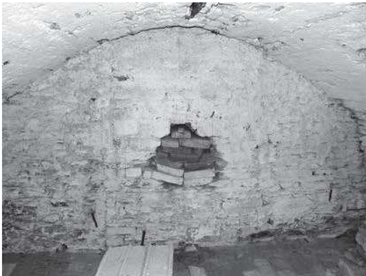
Obdélný sklep s valenou klenbou pod severní částí domu. (foto D. Papajík, 2025)
