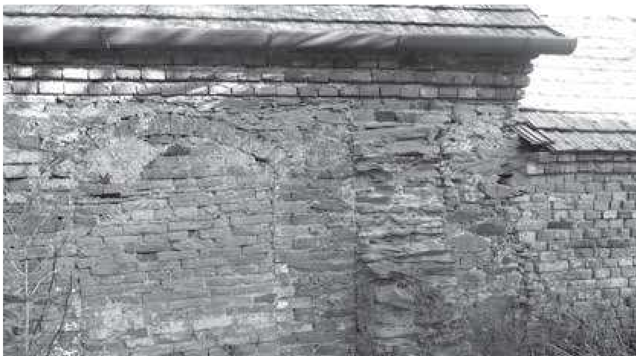
Na severní stěně domu se nachází dodnes částečně dochovaný opěrák a zazděný starší vstup do objektu. (foto L. Hlubek, 2025)
